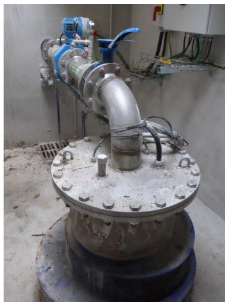
Illustration 4: Exemple de tête de forage (source : dossier d'autorisation environnementale, page 45)
